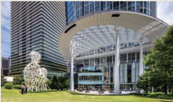
02 虎ノ門ヒルズ 森タワー Toranomon Hills Mori Tower
