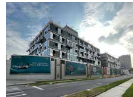
現場写真（2024年11月） 现场照片（2024年11月）
