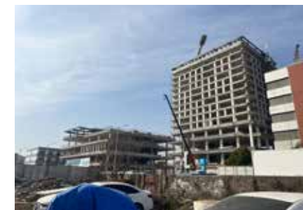
現場写真（2024年3月） 现场照片（2024年3月）
