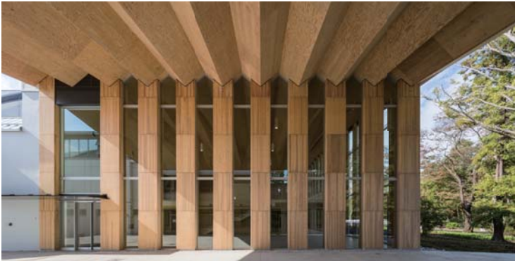
左：柱型 CLT (Cross Laminated Timber：直交集成材) 型枠による列柱／右：LVL による折板構造のエントランス棟。キャンपीーとの連続性により内外の一体的な利用が促進される Left: Colonnade Formed Using Cross Laminated Timber as Column Formwork.
