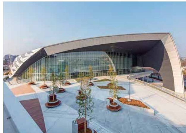
メインアリーナ。地面から立ち上がる3次元の曲面の屋根面で40mの大庇をつくる Main Arena Exterior: Three-dimensional Curve Roof Creates 40m Grand Eave
