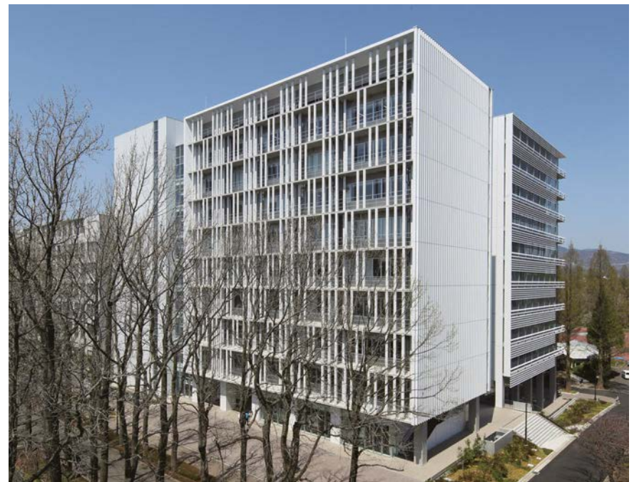
キャンパス建物群のスケールに合わせボリューム分節した外観、スリットから光と風を導く External facade breaks down the volume to harmonize with the scale campus buildings. Slit allows breezes and sunlight to penetrate.
