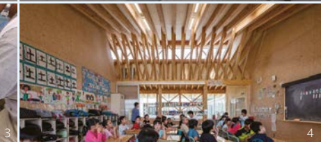
1. 林業研究所による強度試験の様子 | Strength Test Conducted by Forestry Research Institute 2. 森林組合における出荷式の様子 | The Shipment Ceremony at the Local Forestry Cooperative 3. モックアップによる納まり確認の様子 | Confirmation of Details with Mock-ups 4. 小径材の架構による普通教室 | Regular Classroom Structure Using Small Diameter Timber
