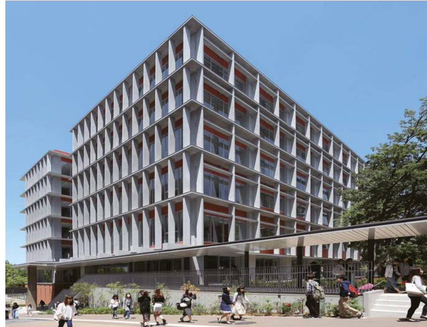
レーモンド建築の特徴であるコンクリートルーバーや庇、赤土色の色彩を基調としたデザインを踏襲した南・西面ファサード South & West Facade Displaying the Characteristic Concrete Raymond Louvers and Eaves Combined with the Legacy Earthy Red Colors
