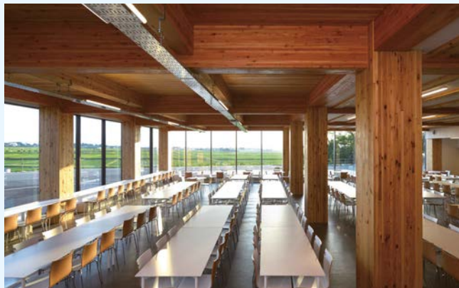
羽黒高等学校 CLT床版あらかわしのカフェテリア Haguro High School Cafeteria with Exposed CLT Lumber Floor Slab
