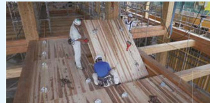
1. 建物南面のファサード | South façade 2. CLT床版の施工の様子 | Laying CLT Floor Slab 3. 木躯体あらかわしの吹き抜け空間 | Open Ceiling Space with Exposed Wood Structure
