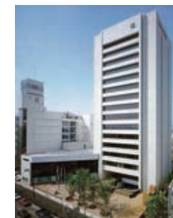
東和銀行本店 The Towa Bank, Ltd., Main Office Gunma, 1979
