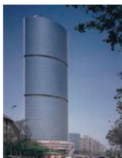
| 京廣中心 Jing Guang Centre China, 1990
