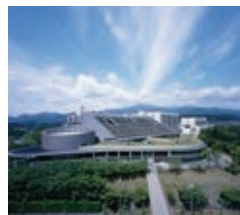
日産先進技術開発センター NISSAN Advanced Technology Center Kanagawa, 2007
