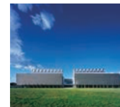
福島白河第一データセンター IDC Frontier Shirakawa Data Center Fukushima, 2013
