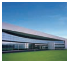
| YKK黒部荻生工場 YKK Kurobe Ogyu Plant Toyama, 1997
