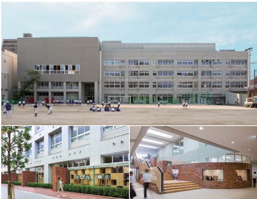
上／少人数化などのクラス編成の変化に対応するための普通教室の中間柱とライトシェルフを組み合わせたサステナブルな外観 top: "Sustainable" frontage showing the middle column and light shelf structures that will allow accommodation to future reduction of class sizes.
