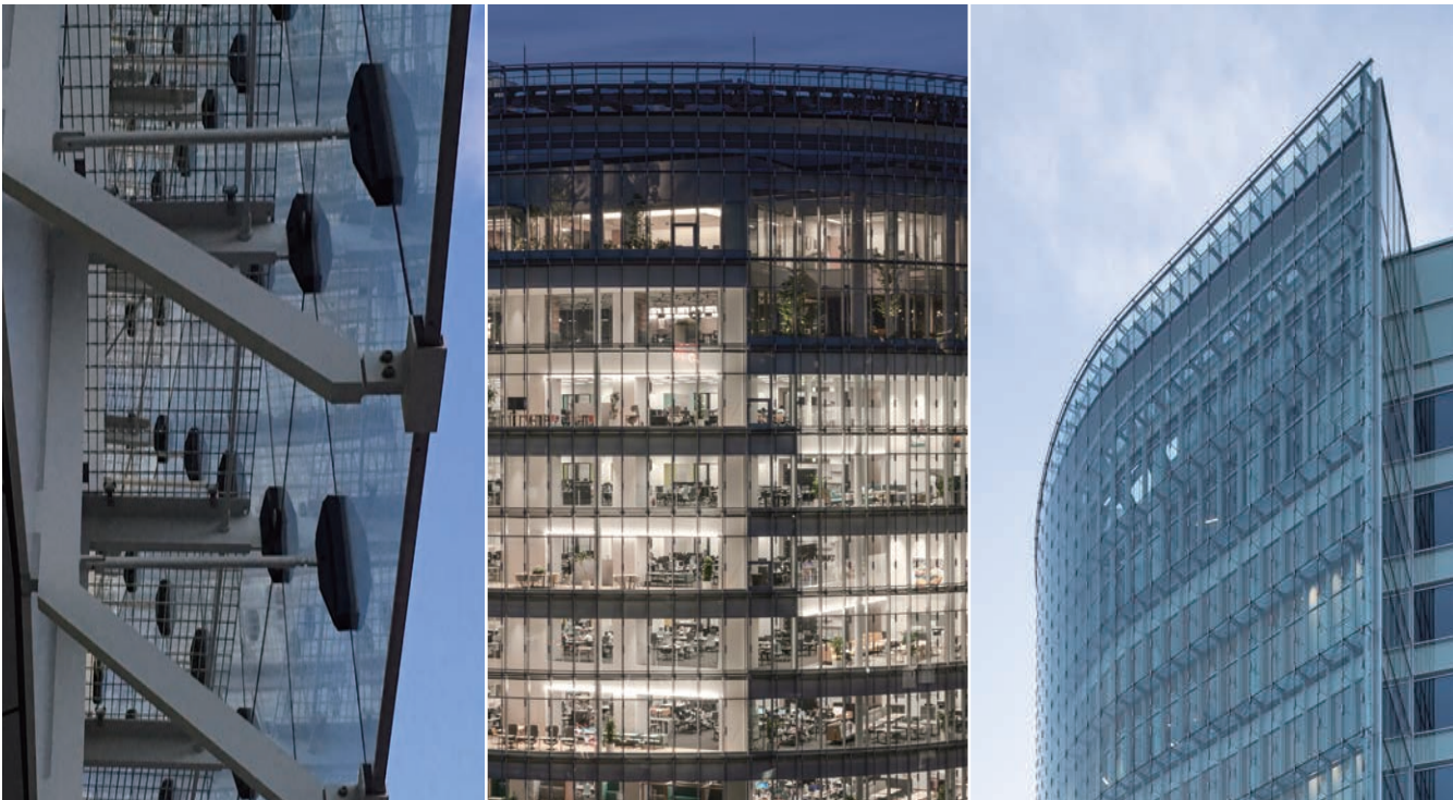
左：シームレスなファサードを形成するMPG工法 中：オフィス内のアクティビティが街に表出する 右：4階床レベルから給気し最上部から排気する9層ヴォイド型のダブルスキン Left: MPG Construction Method Realizing a Seamless Façade, Middle: Activities in the Office Revealed to the City, Right: Double Skin With the Nine-Layer Void Type to Supply Air From the 4th Floor Level and to Exhaust From the Top
