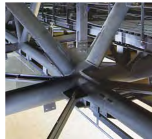
屋根トラス組み立ての様子 Erection of Roof Trusses
