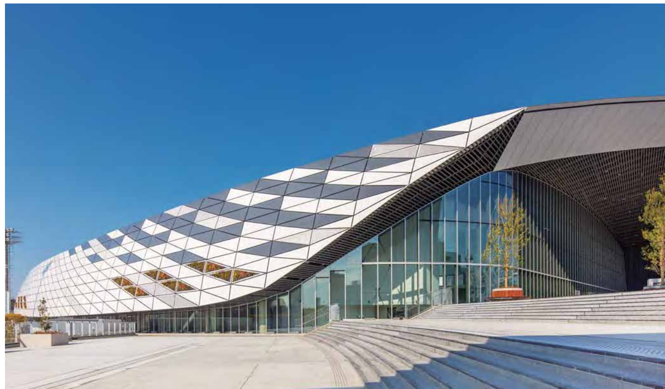
メインアリーナ西側を中央広場から望む。壁面緑化や空気を通すアルミパンチングパネルなどの環境アイテムを適所に設けたダブルスキン West Façade of Main Arena Seen from Central Plaza. Double Skin Cover with Environmental Elements like Green wall and Air Passing Perforated Aluminum Panels in Appropriate Arrangement
