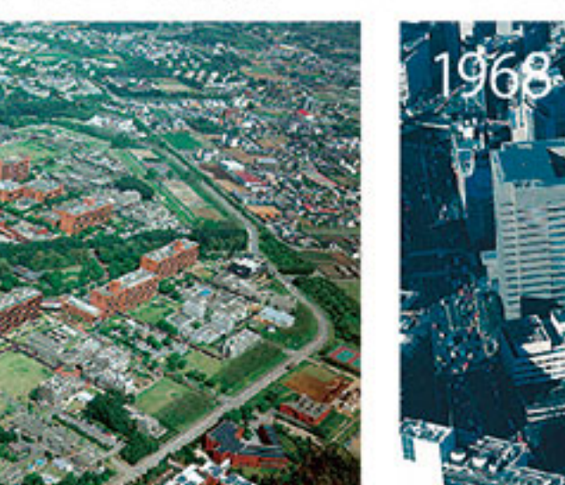
霞が関ビルディング 31m高さ制限を突破し、特定街区制度を活用した国内初の超高層ビル。このビルの設計チームが日本設計を創立しました
