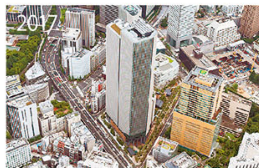
2017 赤坂インターシティAIR 赤坂・虎ノ門線道の西の起点となる大規模緑地の整備によるクルーズスポットの創出や、既存DHCとのエネルギー連携など、地域レベルでの環境負荷低減に向けた取り組みを行っています
