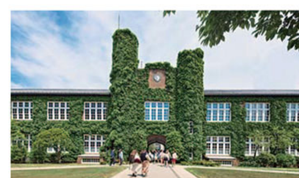
立教大学本館[1号館/モリス館]耐震補強・内装改修
