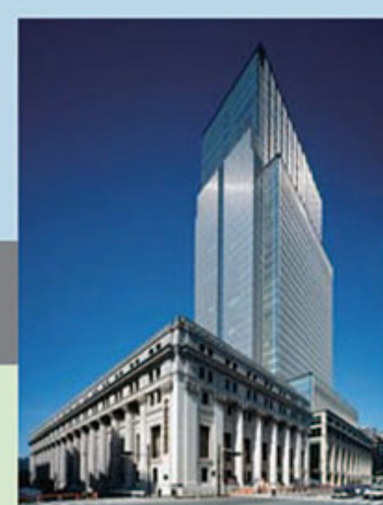
日本橋三井タワー (2005)
