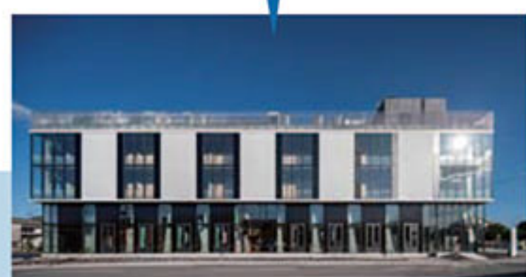
いわき市地域防災交流センター 久之浜・大久ふれあい館 (2016)
