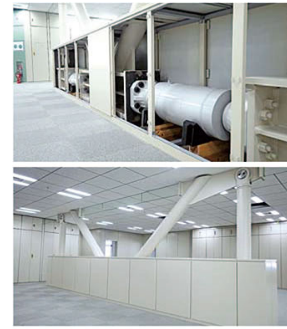
東京都庁の長周期地震動対策に導入されたオイルダンパー式制振装置
