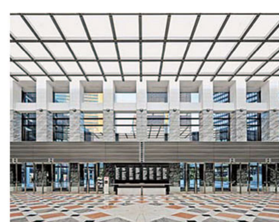
新宿アイランドタワー ロビー天井 耐震補強等改修
