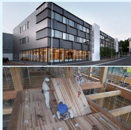
1. 建物南面のファサード | South façade 2. CLT床版の施工の様子 | Laying CLT Floor Slab 3. 木躯体あわしの吹き抜け空間 | Open Ceiling Space with Exposed Wood Structure
