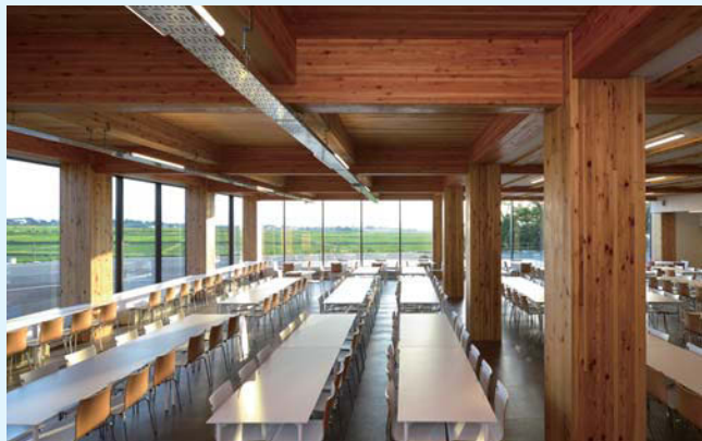
羽黒高等学校 CLT床版あわしのカフェテリア Haguro High School Cafeteria with Exposed CLT Lumber Floor Slab
