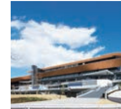
等々力陸上競技場メインスタンド Todoroki Athletics Stadium Main Stand Kanagawa, 2015
