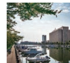
徳島県庁舎 Tokushima Prefectural Office Tokushima, 1986
