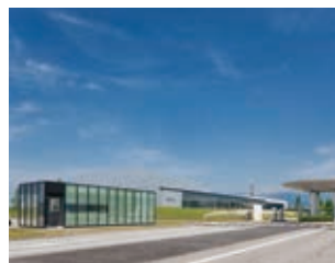
新たに設置した守衛所とエントランスゲート New Guardhouse and Entrance Gate
