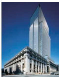
日本橋三井タワー Nihonbashi Mitsui Tower Tokyo, 2005
