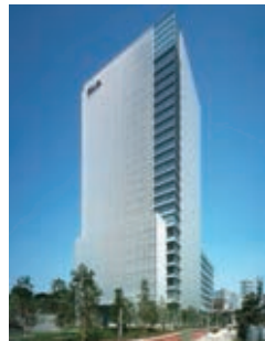
DNP五反田ビル DNP Gotanda Building Tokyo, 2006
