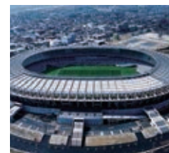
味の素スタジアム AJINOMOTO STADIUM Tokyo, 2000
