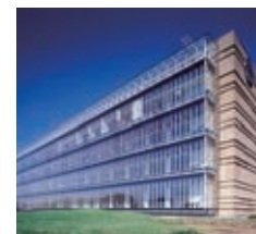
マブチモーター MABUCHI MOTOR Headquarters Office Chiba, 2004
