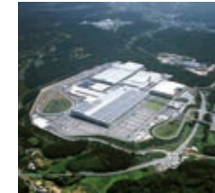
本田技研工業埼玉製作所 寄居完成車工場 The Honda Yorii Final Assembly Factory Saitama, 2013
