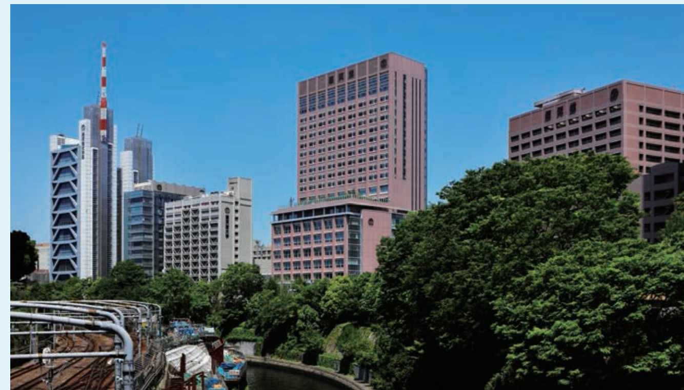
LEED Healthcare Gold 認証を取得した順天堂大学医学部附属 順天堂醫院 B棟 | LEED Healthcare Gold Certified: Block B, Juntendo University Hospital
