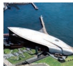
下関市立しものせき水族館「海響館」 Shimonoseki KAIYOKAN Yamaguchi, 2000
