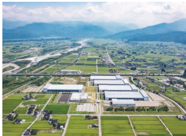
西側正門の敷地全景 背後に立山連峰から連なる山々がそびえる Whole Landscape of the Kurobe Ogyu Plant from the West: Tateyama Range behind the Site
