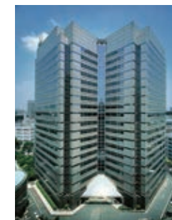
虎ノ門ツインビルディング Toranomon Twin Building Tokyo, 1988
