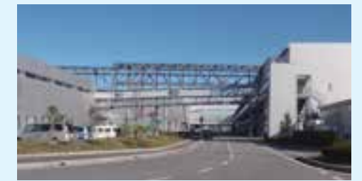
スカイウォークによる無駄のない動線計画 Efficient Circulation Using Skywalks
