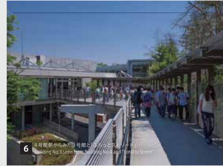
5 4号館と県道をまたぐ「ふらっとストリート」 Building No.4 and "Furatto Street" crossing over the road.
