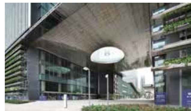
大庇の下のオフィス入口広場 | Semi-Open Entrance Space to Office under Great Eave
